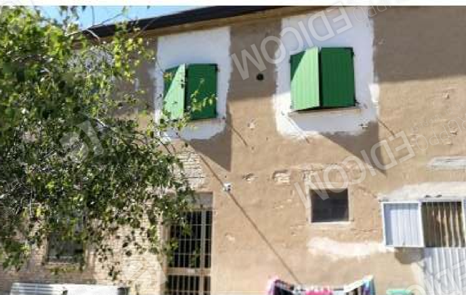
Vista del fabbricato principale
