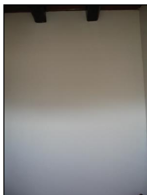
parete che chiude l'originario collegamento interno fra i due piani
