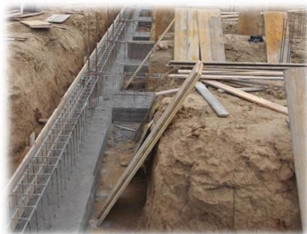
Le travi di fondazione in cemento armato, delle dimensioni risultanti dai calcoli statici, saranno realizzate con impiego di calcestruzzo a resistenza e con ferro FeB44K ad aderenza migliorata. La profondità, le sezioni, il dosaggio del calcestruzzo, come pure la sezione e il tipo di ferro saranno stabiliti dal tecnico calcolatore così come saranno meglio indicate sugli elaborati dei C.A.
