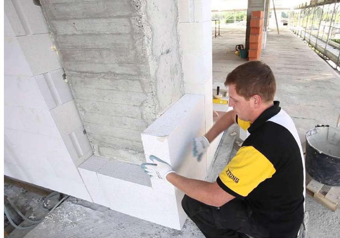
Tutti gli elementi strutturali sopradescritti non sono termicamente isolati, quindi se esposti alle temperature esterne danno origine ai “ponti termici”, i quali provocano notevoli dispersioni di calore e una riduzione della temperatura superficiale interna con conseguenti sprechi energetici e fenomeni di condensa causa di muffe e situazioni insalubri.
