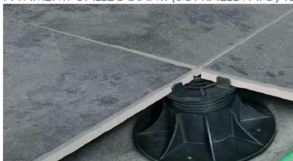
È prevista la fornitura e posa di pavimentazione sopraelevata per esterni su tutti i terrazzi ai piani, in gres ceramico fine porcellanato ad alte prestazioni, formato e tipologia a scelta del progettista, spessore massimo 20mm.
