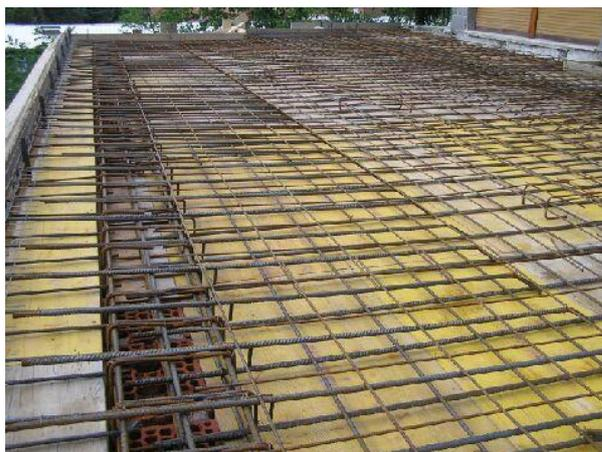
I solai in calcestruzzo e laterizio saranno costituiti da travetti prefabbricati, distanziati da elementi forati (pignatte) e gettati in opera e soletta di completamento in calcestruzzo armato. I travetti e la soletta saranno eseguiti in c.l.s., in prossimità dei balconi e dei terrazzi saranno posati elementi disgiuntori per l'eliminazione dei ponti termici.
