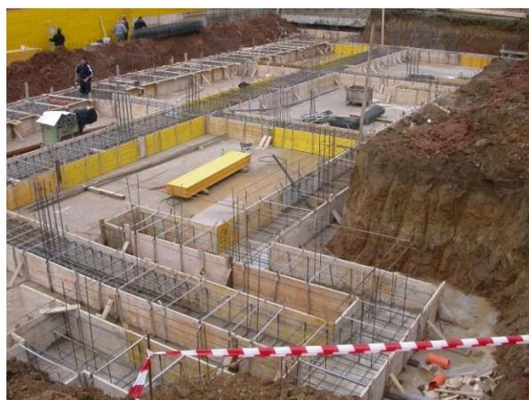
Le fondazioni e le strutture in elevazione dei fabbricati (pilastri, setti, muri, muri di contenimento, scale interne ed esterne, travi, balconi, ecc.), nonché il primo solaio di copertura del piano seminterrato e l'ultimo della copertura saranno eseguiti in c.a. con la rigorosa osservanza delle disposizioni di Legge e delle prescrizioni tutte che verranno impartite dalla Direzione Lavori sia nella fase di elaborazione del progetto esecutivo delle strutture che nel corso dei lavori.
