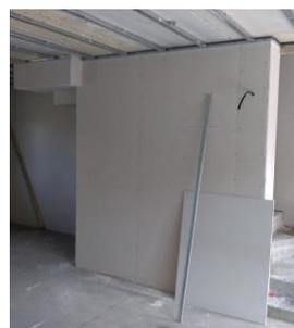
I divisori verticali dei singoli locali interni saranno eseguiti in lastre di cartongesso montate su struttura metallica dello spessore finito delle pareti cm 10/12.
