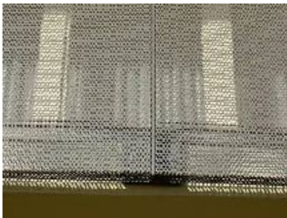
Parapetti in lamiera microforata
