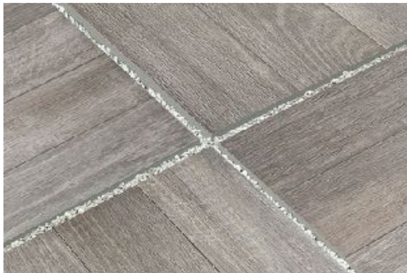
Pavimentazione esterna in ceramica
