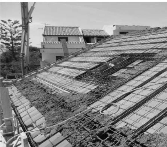
L'edificio avrà copertura del tetto a falda in laterocemento; il manto di copertura sarà realizzato con materiali di elevata prestazione e materiali isolanti, atti a garantire la classe energetica di appartenenza. Superiormente sarà installata la linea vita, certificata, per garantirne la futura manutenzione in sicurezza, e a norma di legge; Sempre sulla copertura verranno installati i pannelli dell'impianto fotovoltaico.
