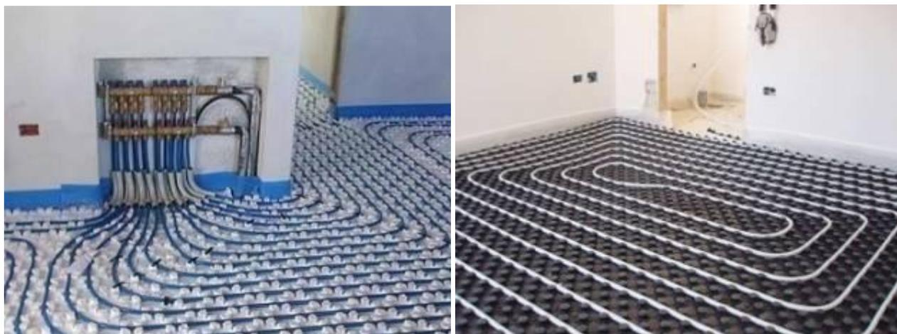
L'impianto consentirà di ottenere un elevato comfort in quanto il calore verrà irradiato nei singoli vani in modo uniforme su tutta la superficie di calpestio.
