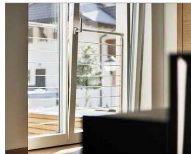
E' prevista l'installazione di serramenti con vetro basso emissivi in LEGNO colore a scelta della D.L.. Tutti i vetri a tutti i piani saranno di tipo antisfondamento ad elevato abbattimento acustico.
