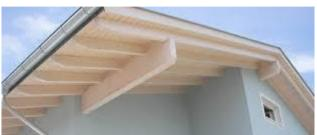
Il manto di copertura sarà realizzato con coppo di Francia, di colore grigio, con finitura liscia granito, della ditta Wierer, comprensivo di colmi e pezzi speciali.
