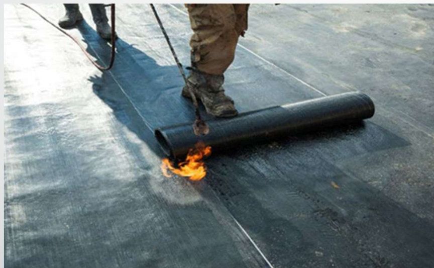
Fig. 6 - Impermeabilizzazione di tenuta con guaina applicata a fiamma
