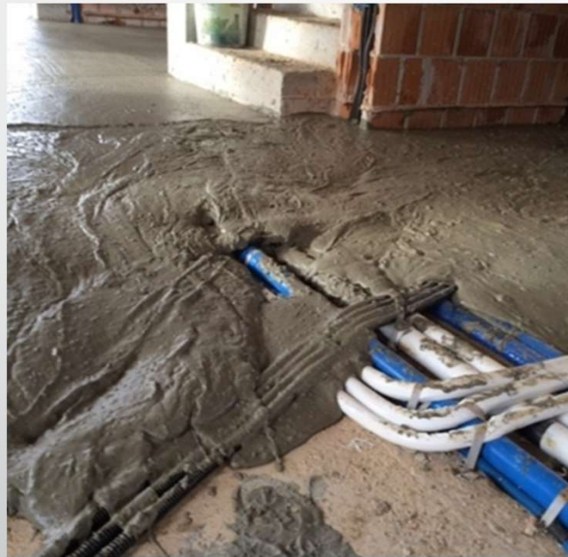
Figura 15 – esecuzione sottofondo alleggerito
