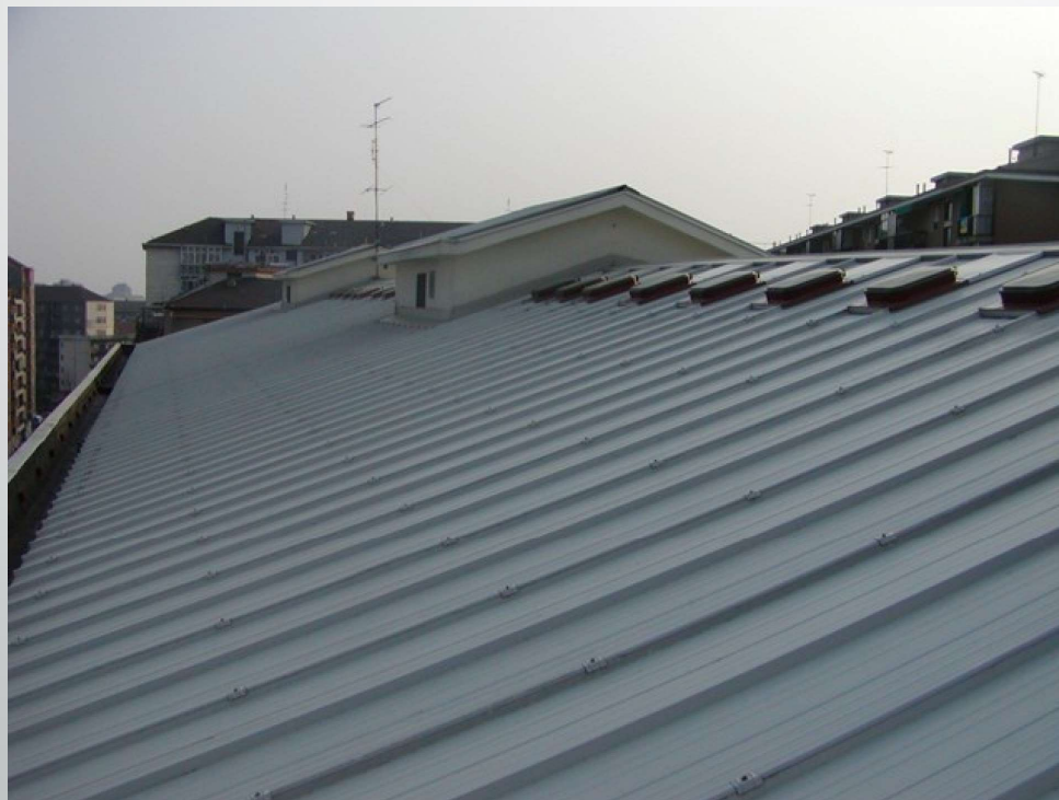
Fig. 9 – Copertura in lamiera grecata
