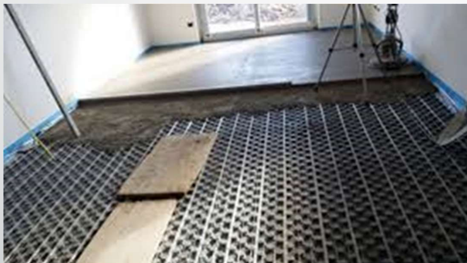
Figura 16 – esecuzione massetto radiante
