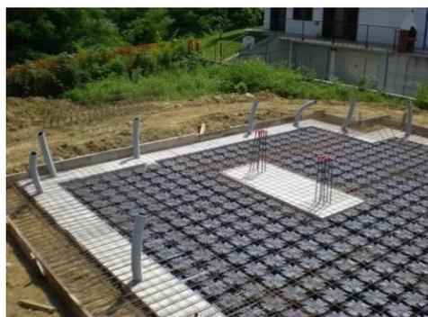
Il pavimento del piano cantinato verrà eseguito con sistema a **vespaio aerato**. Esso verrà eseguito con calotte plastificate a **igloo** di H30 circa che verranno riempite completamente in calcestruzzo con interposta rete elettrosaldata di ripartizione D 6 20x20. Tale sistema permetterà di avere il pavimento del piano cantinato completamente ventilato e sollevato.
