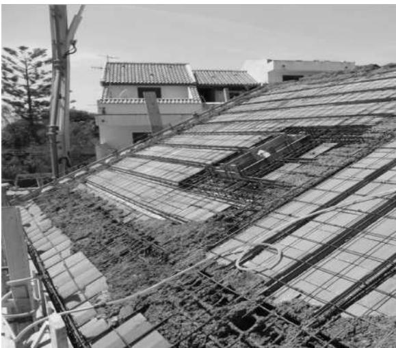
L'edificio avrà copertura del tetto a falda in laterocemento; il manto di copertura sarà realizzato con materiali di elevata prestazione e materiali isolanti, atti a garantire la classe energetica di appartenenza.
