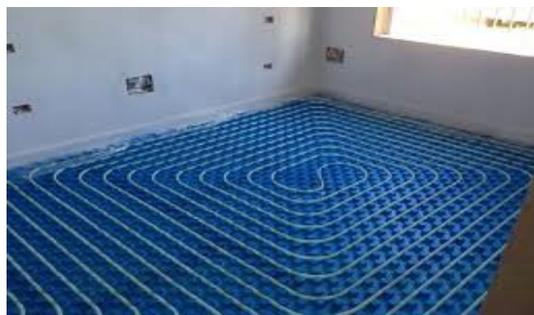
I locali sono riscaldati mediante sistema di pannelli radianti a pavimento. La regolazione della temperatura in ogni ambiente avviene per mezzo di regolatori ambiente che agisce sui singoli circuiti dei pannelli radianti.
