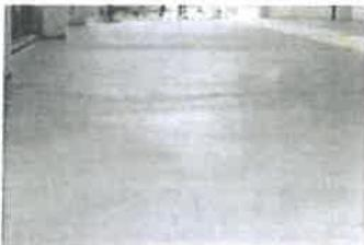
*La pavimentazione del piano interrato, sarà di tipo monolitico ad alta resistenza, costruita in opera, con cls. finemente fratazzato ed arricchito superficialmente con quarzi naturali, nella colorazione a scelta della D.L.*
