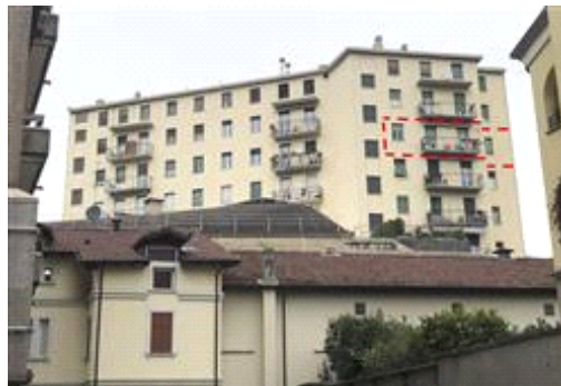
Prospetto sud su via Caprera - Appartamento al sesto piano
