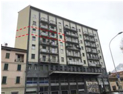
Prospetto nord su via Costituzione - Appartamento al sesto piano
