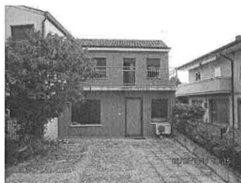
Lotto 3 – Porzione edificio ad uso ufficio P.T. (Agnà)
