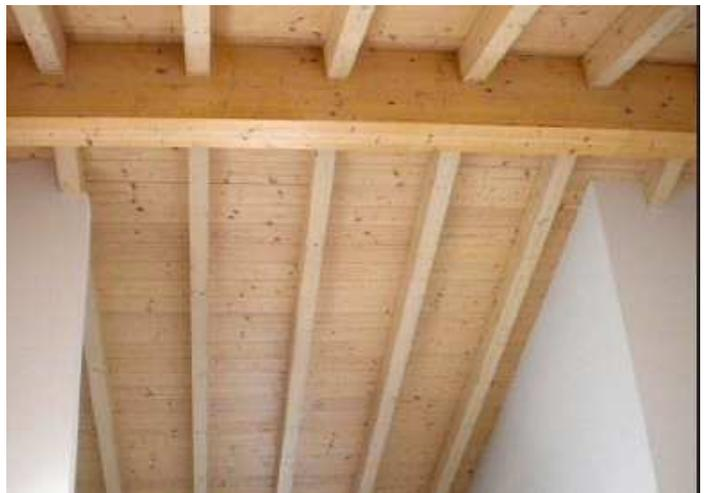
spessore di 120mm con appositi correntini per la realizzazione di un tetto microventilato. Al di sopra di tale elemento verranno posati i coppi con opportuni dentelli antiscivolamento.
