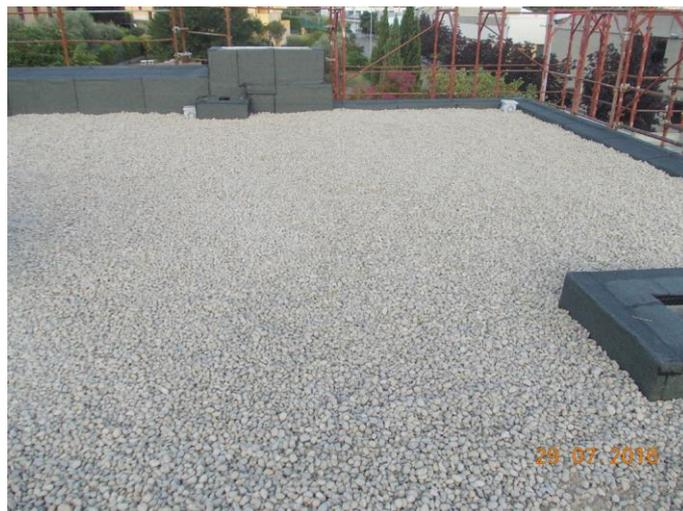
Strato protezione in ghiaio per la copertura
