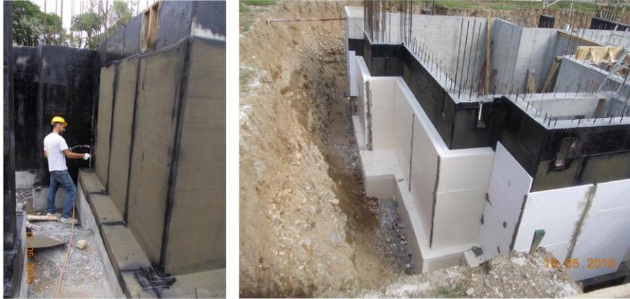
Impermeabilizzazione e Isolamento muri interrati
