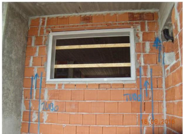
Tamponamenti perimetrali in poroton con falsitelai coibentati a taglio termico
