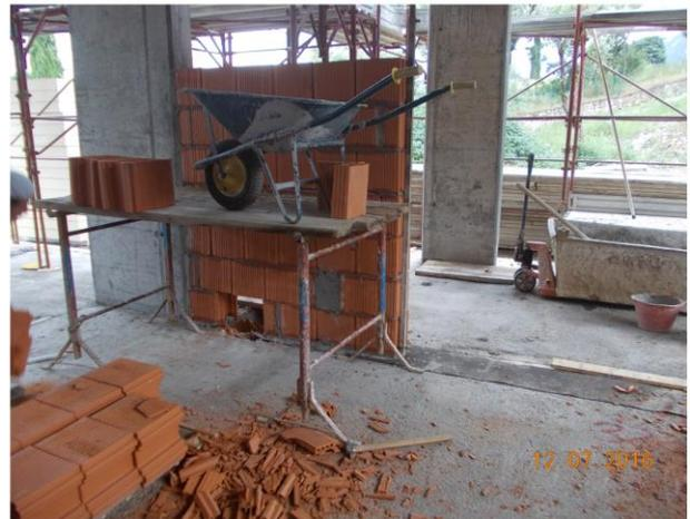
Tamponamento in Poroton con guaina bituminosa antirisalità umidità
