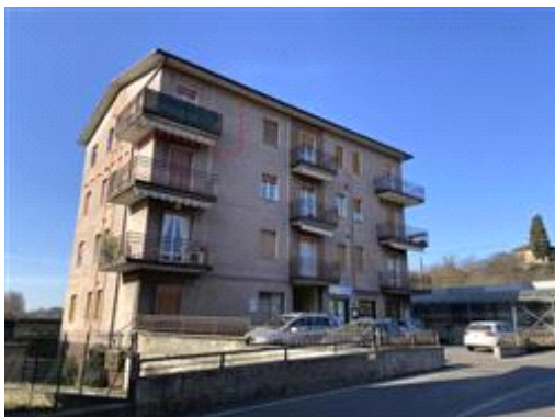
Prospetto sud-ovest e prospetto nord-ovest su via Roma
