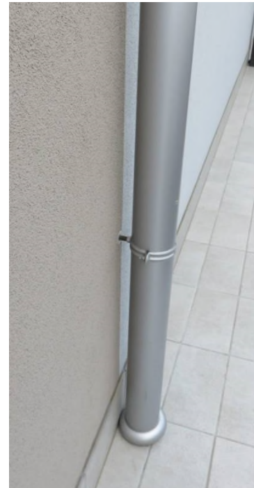
Pluviali e Grondaie in lamiera d'acciaio preverniciato colore grigio silver spess. 6/10
