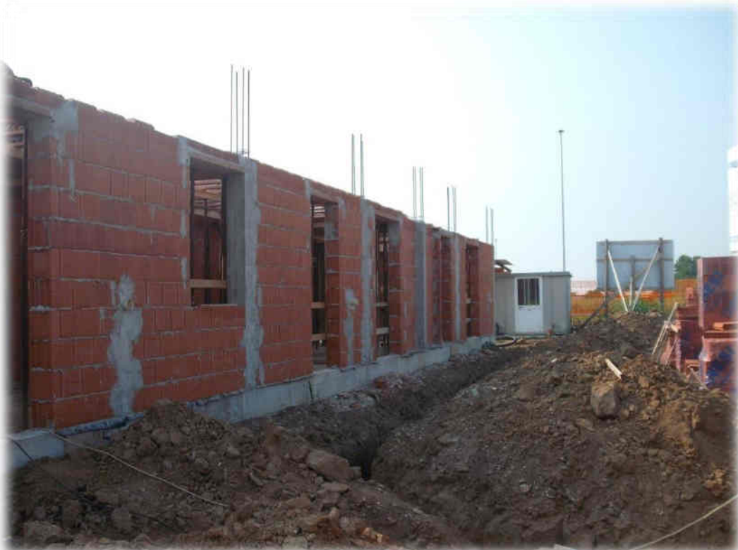
STRUTTURA PORTANTE "MISTA"
